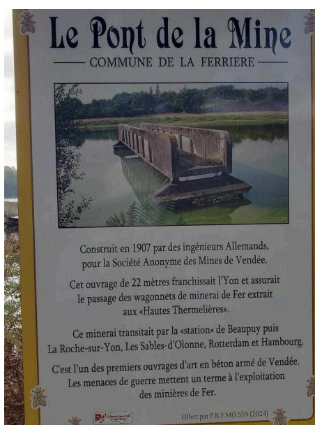
Le Pont de la Mine de Moulin Papon à La Ferrière en Vendée
